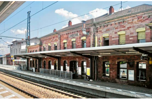
Landstuhl, Rheinland-Pfalz: Tödliche Attacke auf einen Zugbegleiter.
